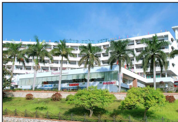
Dự án thoát nước KS Công Đoàn Hạ Long
